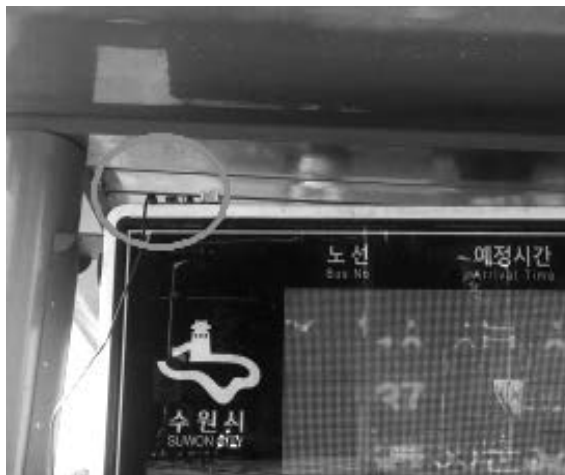
〈그림 20〉 비컨 설치 사진
