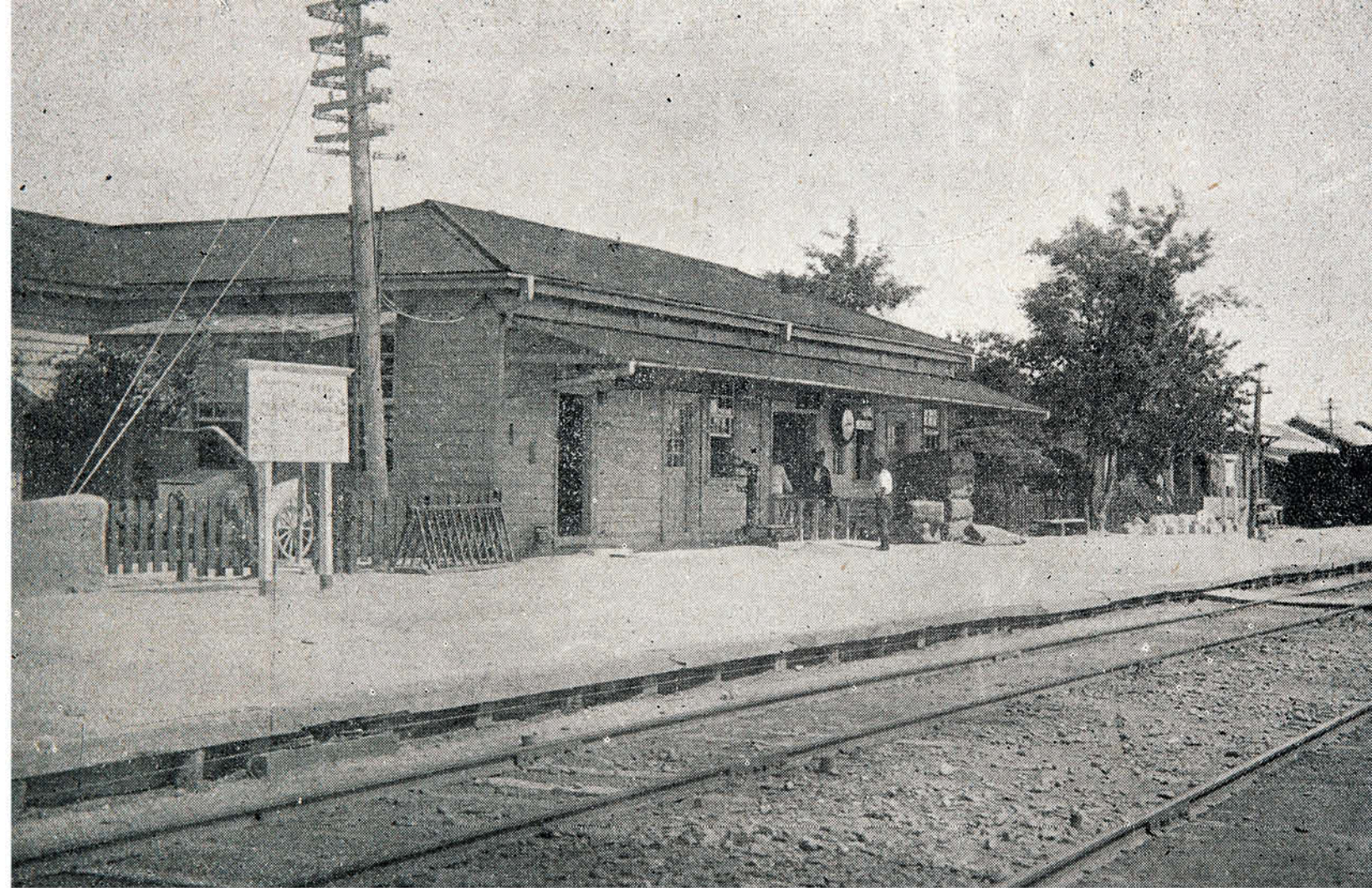
수원역 구내에 설치된 시계(사카이 마사노스케, 『수원』, 1923)
