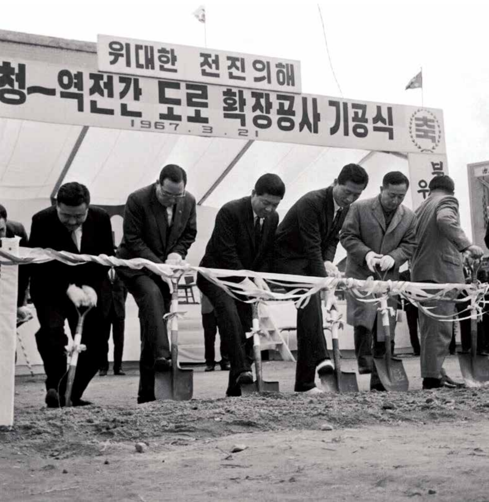
수원시청~역전 간 도로 확장공사 기공식(1967년, 국가기록원 소장)
