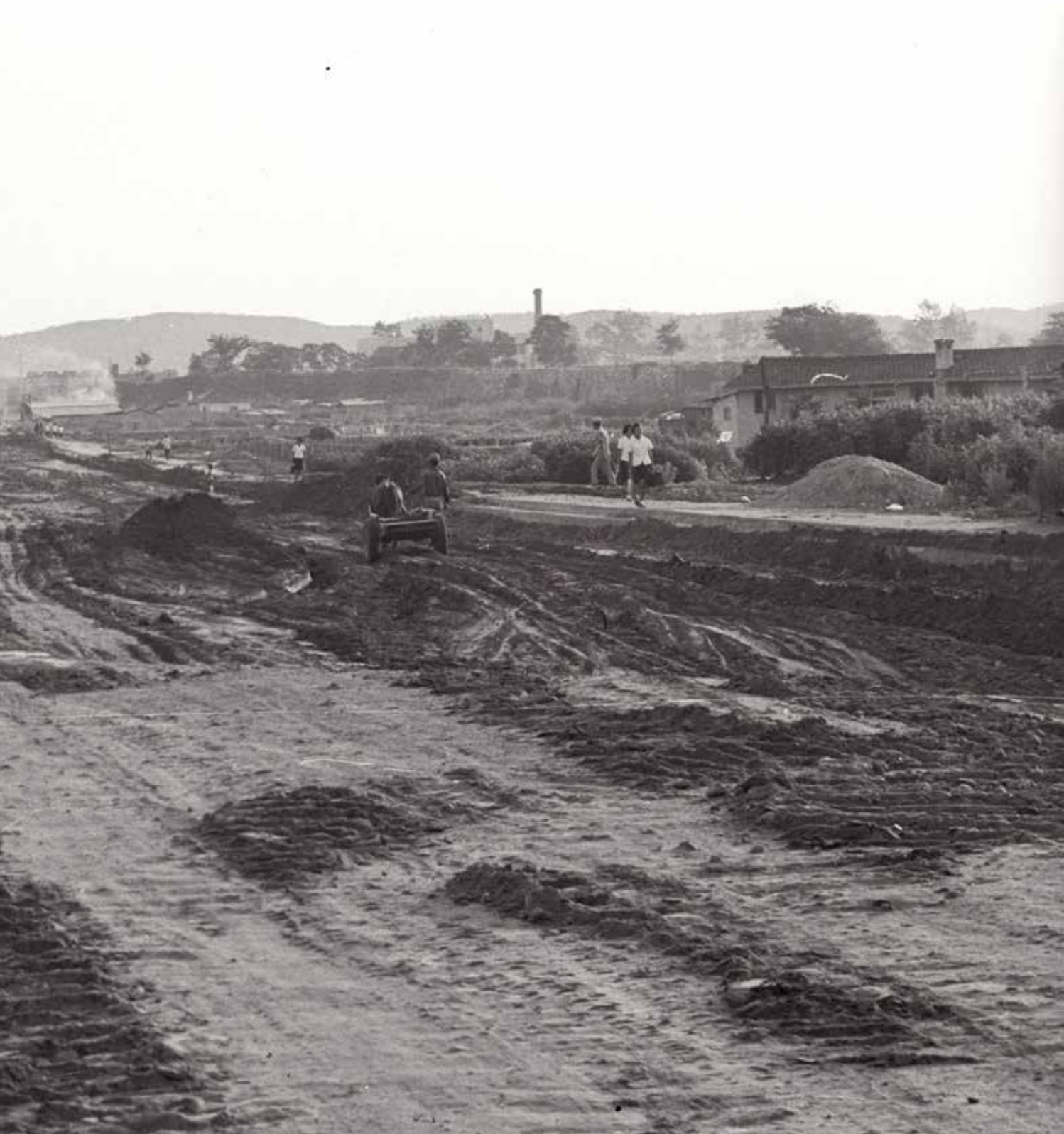
서문선 도로 공사(1972년, 수원시청 소장) 장안문과 화서문을 오가는 도로가 넓혀지고 있다. 넓어진 도로만큼 사람들 사이도 멀어진 듯하다.
