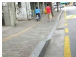
경계석 턱 낮추기와 보도 기울기로 굴곡이 심한 보도
