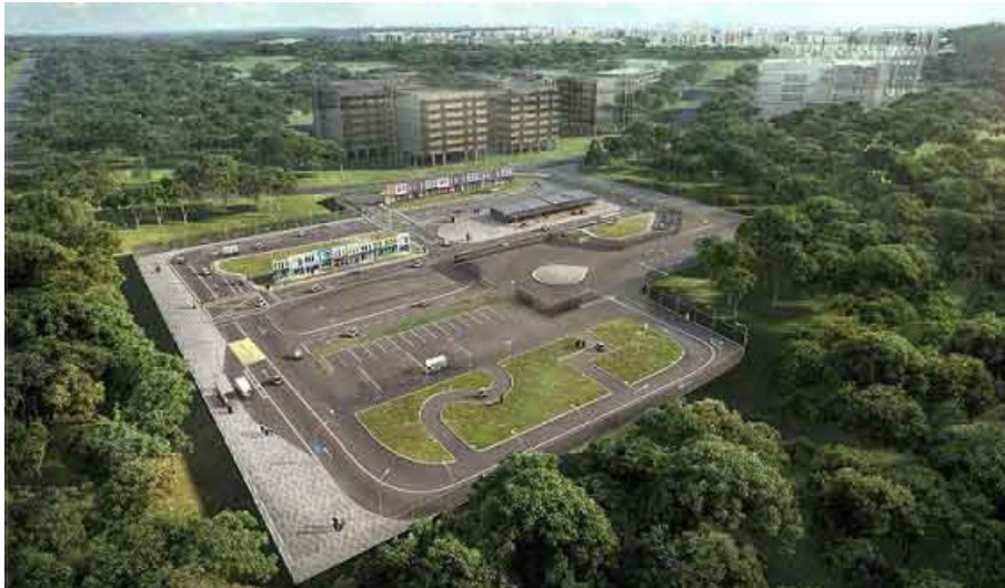
〈그림 2-10〉 CETRAN Test Circuit
