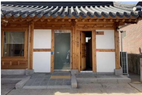
〈화서사랑채 화장실 : 장애인용화장실 별도 설치〉
