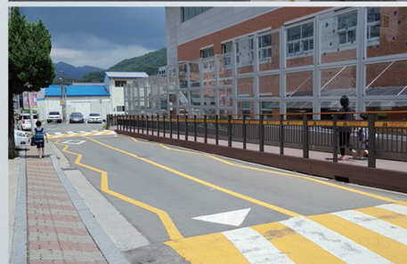
안전 사각지대인 차폐식재 제거 후 울타리 투명방음벽 설치
